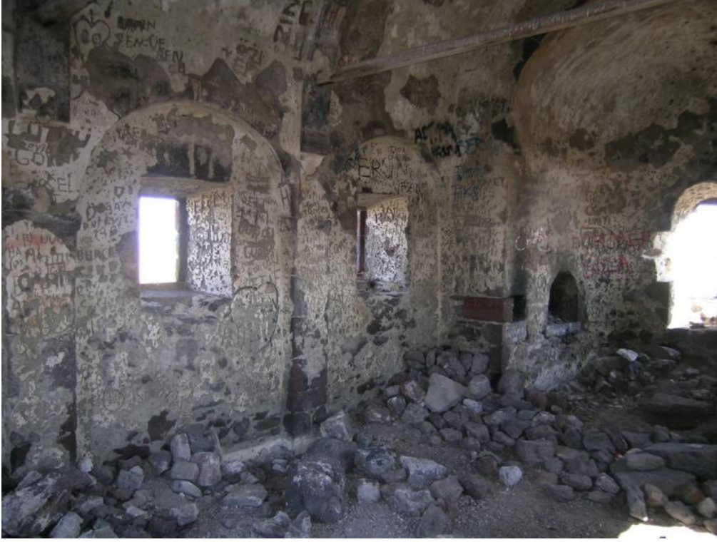
Resim 6: Şapelin içi, kuzey duvar (2010)
