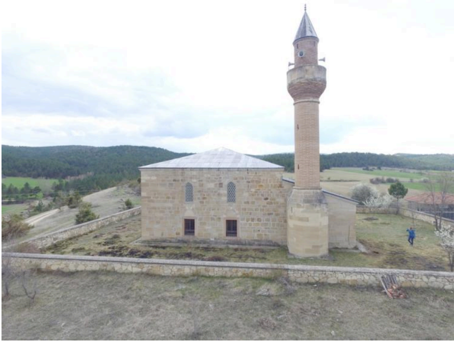
Fotoğraf 7: Rüstem Paşa Camii doğu cephesi ve minaresi, 2018.
