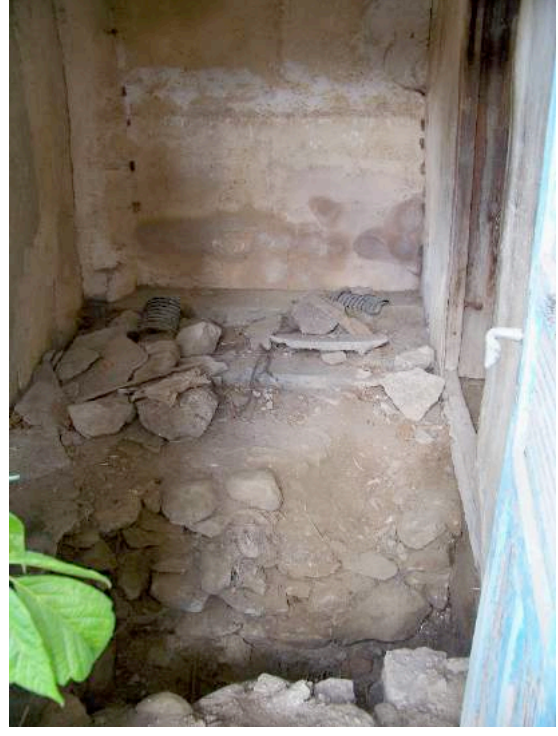
Fotoğraf: 9 Alören Köyü Camii giriş ünitesi.
