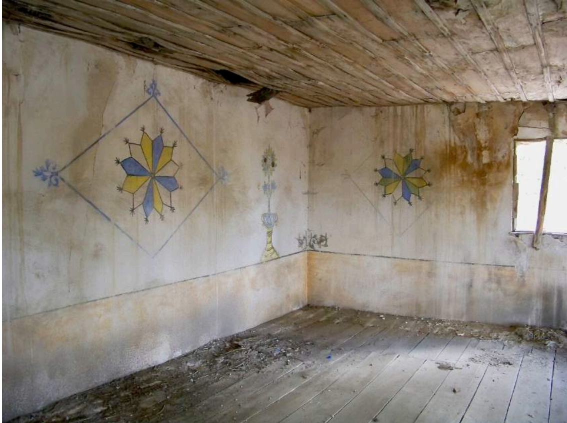
Fotoğraf: 16 Alören Köyü Camii mahfil katı kuzeydoğu köşe.
