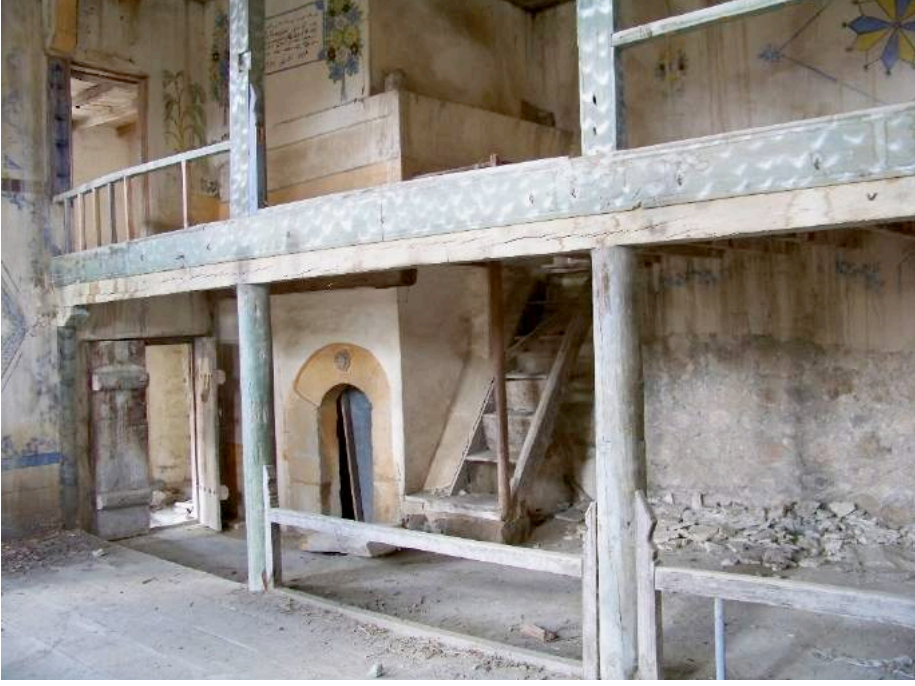
Fotoğraf: 13 Alören Köyü Camii harim mekânı kuzeybatıya bakış.
