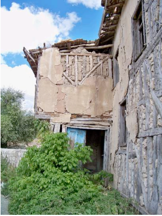
Fotoğraf: 8 Alören Köyü Camii giriş ünitesi.
