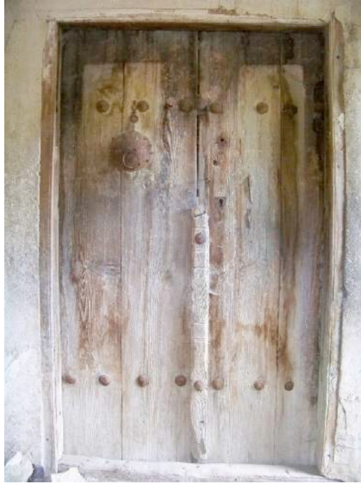
Fotoğraf: 10 Alören Köyü Camii harim kapısı.
