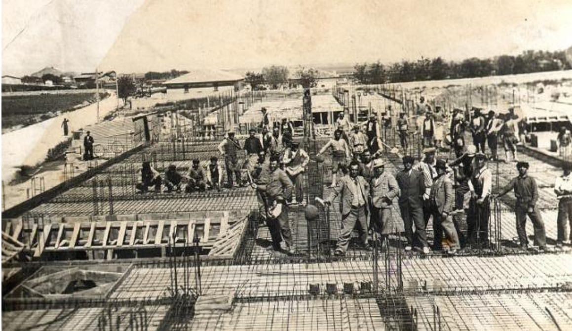
Resim 3. Memleket Hastanesinin Yeni Binası İnşaat Halinde
