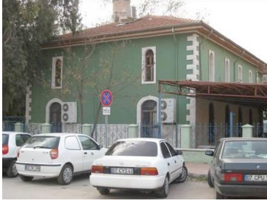
Resim 12. Güneydoğu Cepheden, Doğu Cephede Yer Alan Pencereler ve Sundurma (2009).
