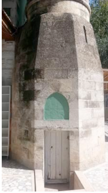
Resim 10. Minare, Giriş Kapısı (2017).
