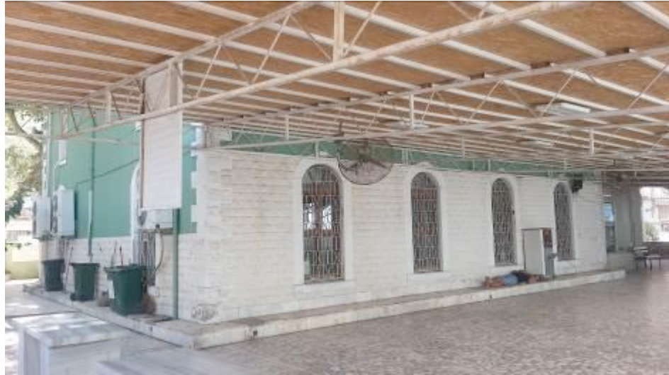
Resim 13. Doğu Cephe, Duvar Yüzeyi, Kaplama Taş Malzeme (2017).
