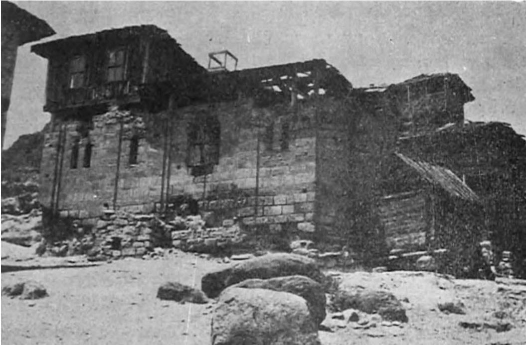
Şekil 4: Kilisenin 1950'li Yıllardaki Durumu (R. Duyuran, 1952, s. 195)
